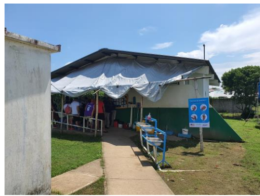
Figura 2: Entrada principal a Clínica Asistencial.
